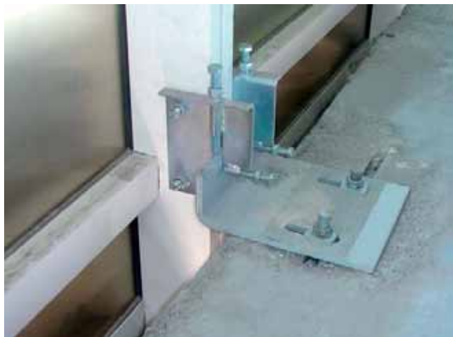
Мандела Родэс проект, Южная Африка: Крепление навесного фасада (Curtain Wall) с помощью зажимов HCW-B2 на анкерных шинах НТА.
