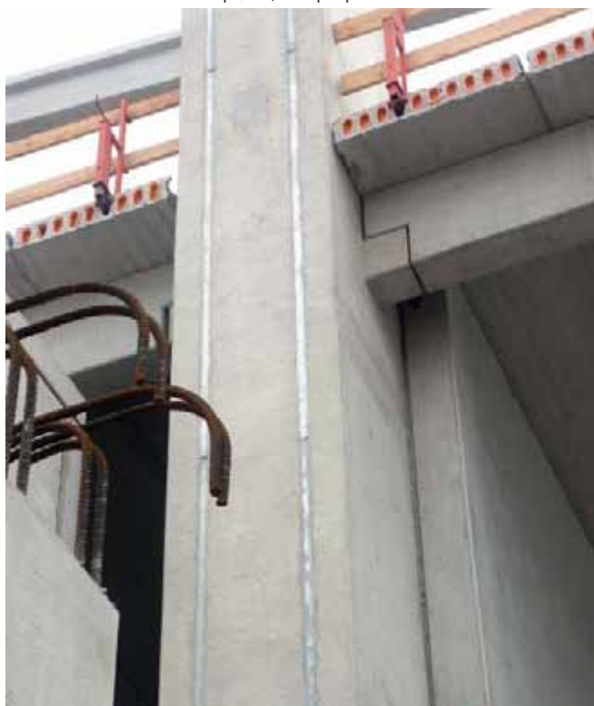
Вертикальная установка шин HTU для фасадных конструкций
