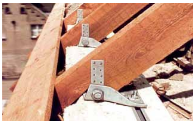
Стропильный башмак HALFEN тип HSF 6/12
