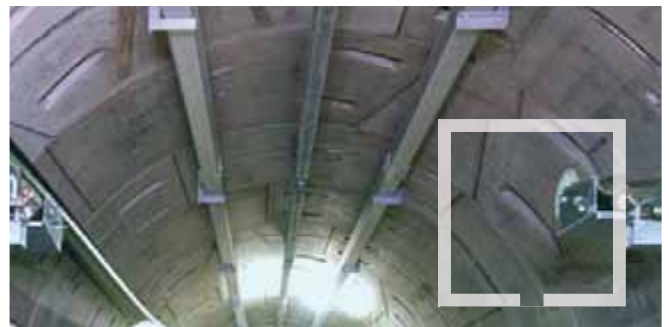
Гнутые шины Halfen в Тюбинге
