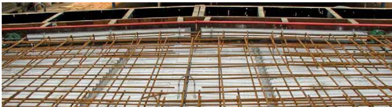
Установка шин HTU на торце ж/б перекрытия
