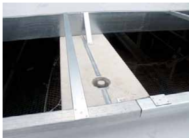
Шины HTU на несущих элементах
