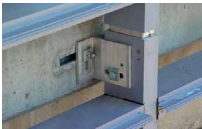
Крепление фасада типа «ригель – стойка» с помощью зажимов HCW-ED на анкерных шинах НТА
