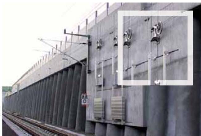
Тоннельное строительство: Крепление натяжных устройств контактной сети
