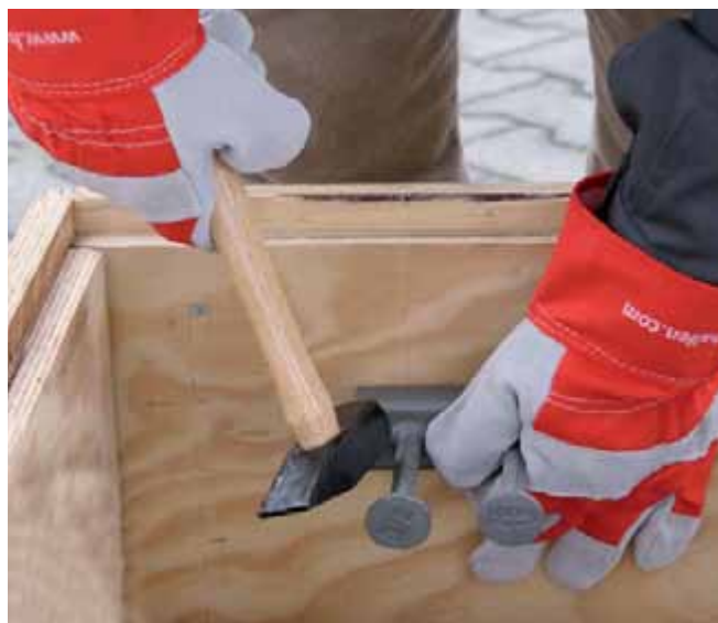
Шины Halfen прибить к опалубке гвоздями
