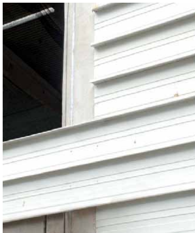
Смонтированные фасадные элементы
