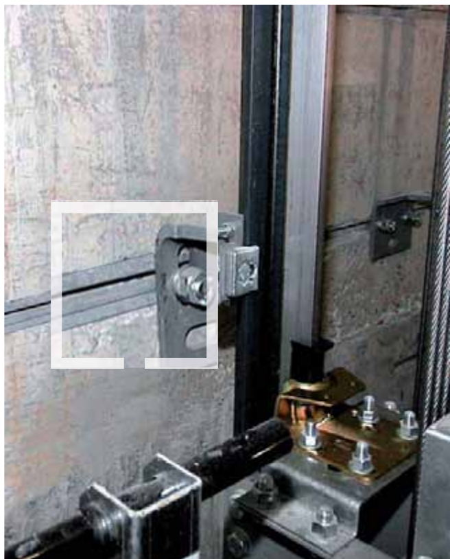
Строительство лифтов: Крепление направляющих
