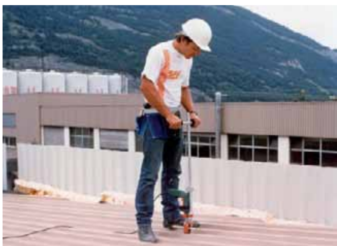
Крепление профнастила
