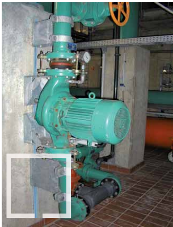
Крепление инженерного оборудования
